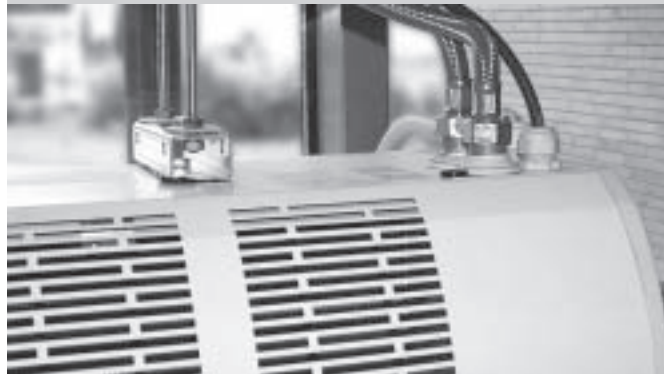
Obrázek 13 – připojení topné vody (ohebné hadice)
